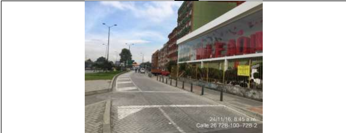
Fotografía No. 1 Vista panorámica del elemento no regulado constituido por una edificación tipo estructura montada sobre pilares y con fachada en vidrio orientada hacia la vía pública con publicidad en su interior, ubicado en la Avenida Calle 26 No. 73 – 04, instalado sin autorización por parte de la Secretaría Distrital de Ambiente.
